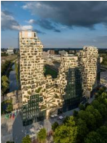
IHA2024-25_MVRDV_Valley_Aussen_Ossip van Duivenbode
